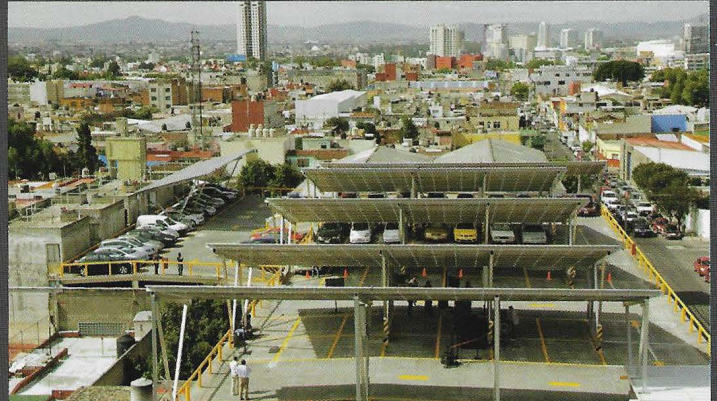
Eco Park UPAEP - Sistema Generador de Energía -, ahorra energía equivalente al consumo de 177 casas mexicanas.
