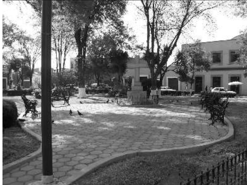
La obra consistió en la rehabilitación del área sin modificar el entorno
