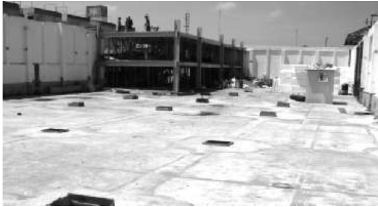
Avances de la obra ubicada en 23 Sur 1310
