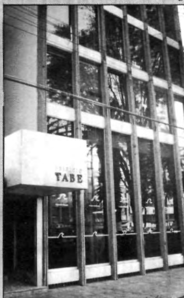
Nuevas instalaciones UPAEP
