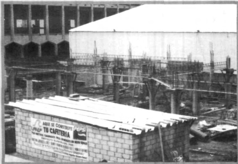
SE AVANZA RÁPIDAMENTE EN LA CONSTRUCCIÓN DE LA CAFETERÍA
